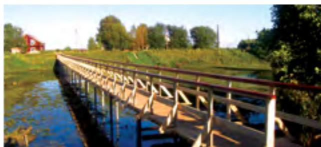
Пешеходный мост – проект ТОС «Левковка»
