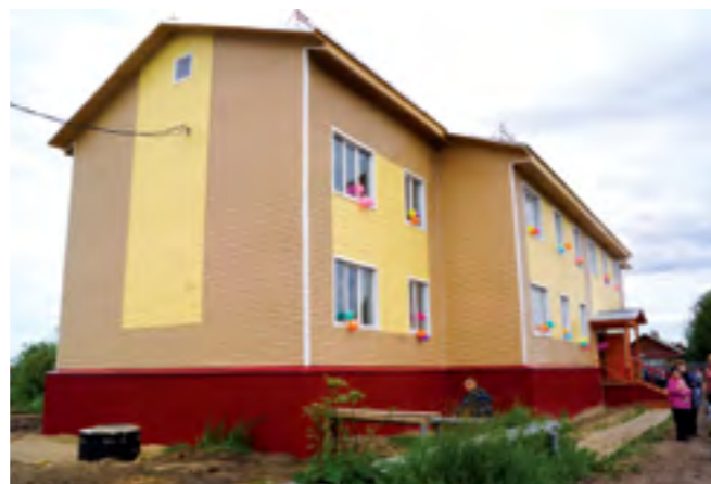
Реализация программы по переселению из аварийного жилья – новый дом в д. Хорьково
