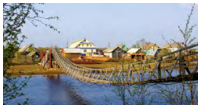
Подвесной мост в д. Шихириха
